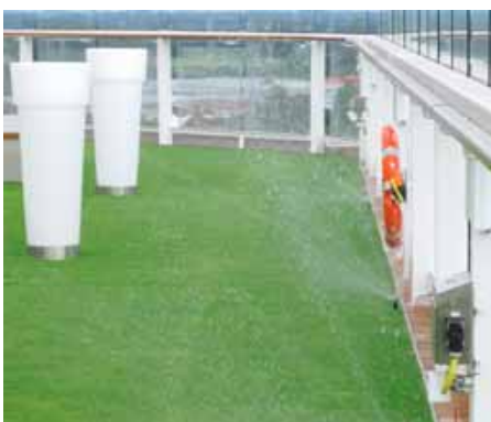
Die am Rand installierten Halbkreis-Versenkregner im Einsatz auf dem Rasendeck des Luxusdampfers.
